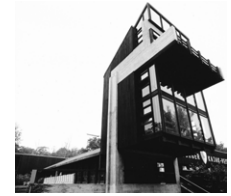
PRESSE- UND ORGANISATIONS- GEBÄUDE AN DER KANUSTRECKE 1971 | AUGSBURG
